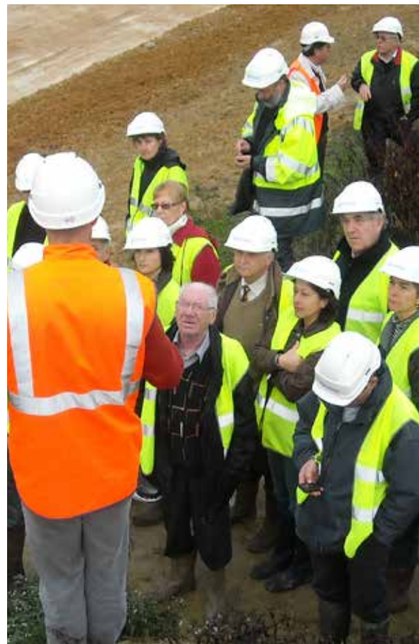
Décembre 2009, visite du chantier de l'A65 à Cazères sur l'Adour
