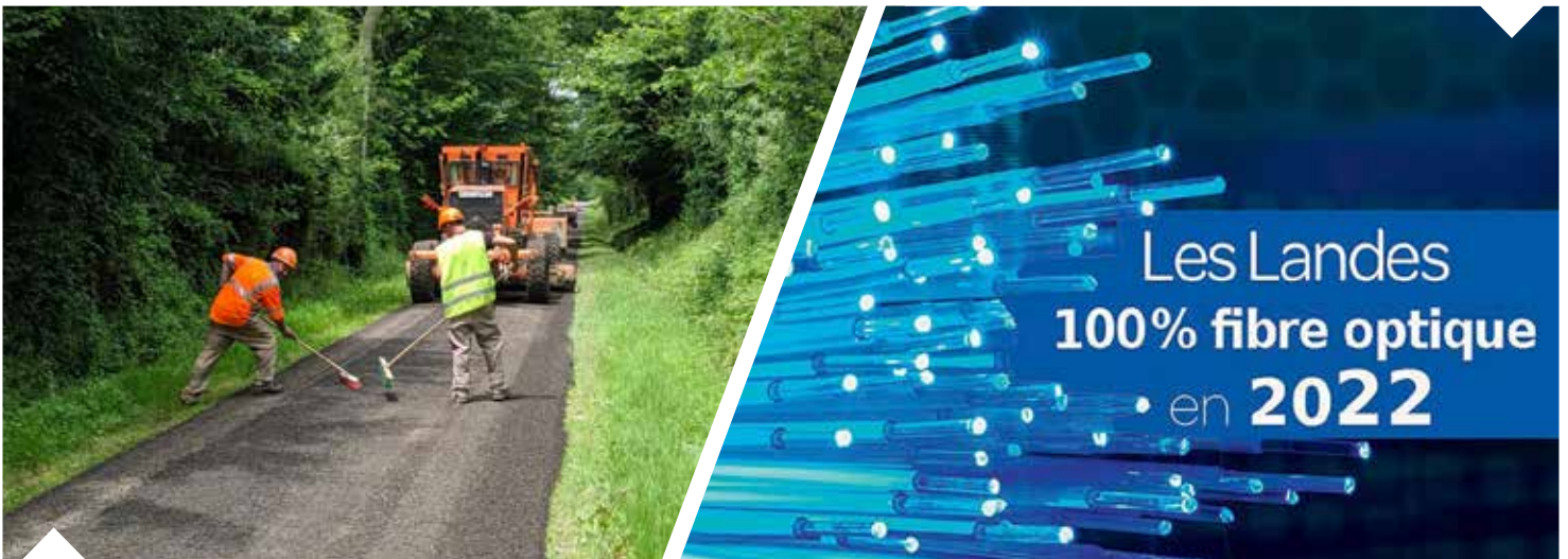
Rénovation de 37 000 m 2 de voirie en 2019
