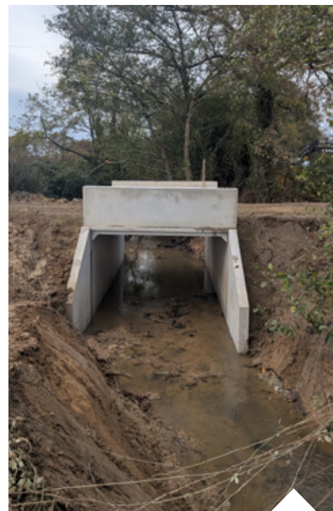
Les nouveaux cadres et têtes du pont du Gioulé à Cazères-sur-l'Adour ont été fabriqués localement par l'entreprise Prêfadour.
