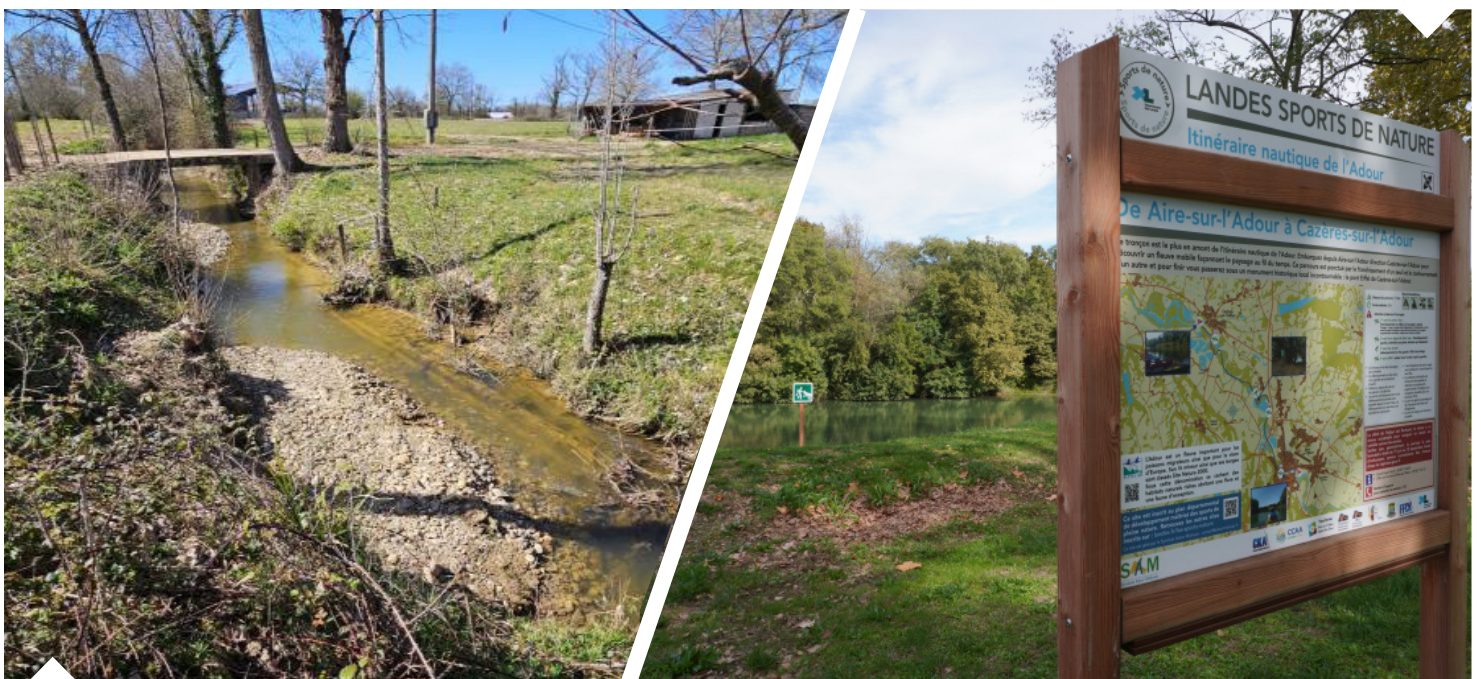
Des travaux de renaturation du Gioulé amont entre Cazères-sur-l'Adour et Le Vignau ont été réalisés en mars 2025.
