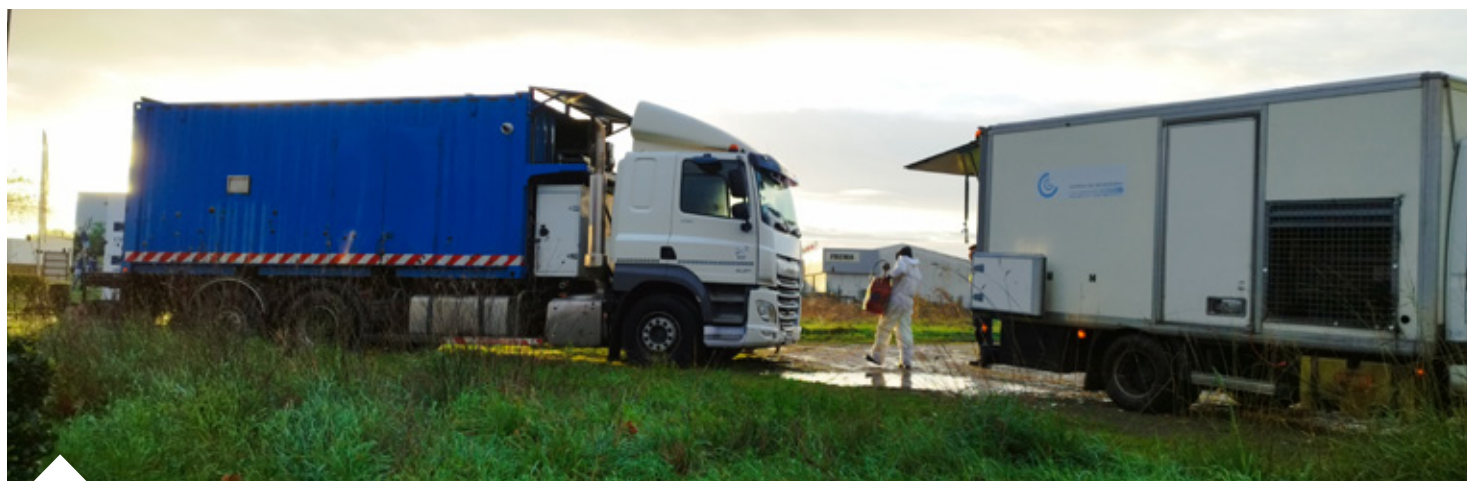
Une réhabilitation sans tranchée des réseaux d'assainissement a été engagée à Grenade-sur-l'Adour courant novembre 2025.
