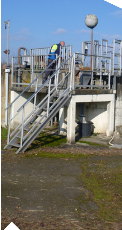
Une mise en conformité de la station d'épuration de Grenade sur l'Adour est engagée.
