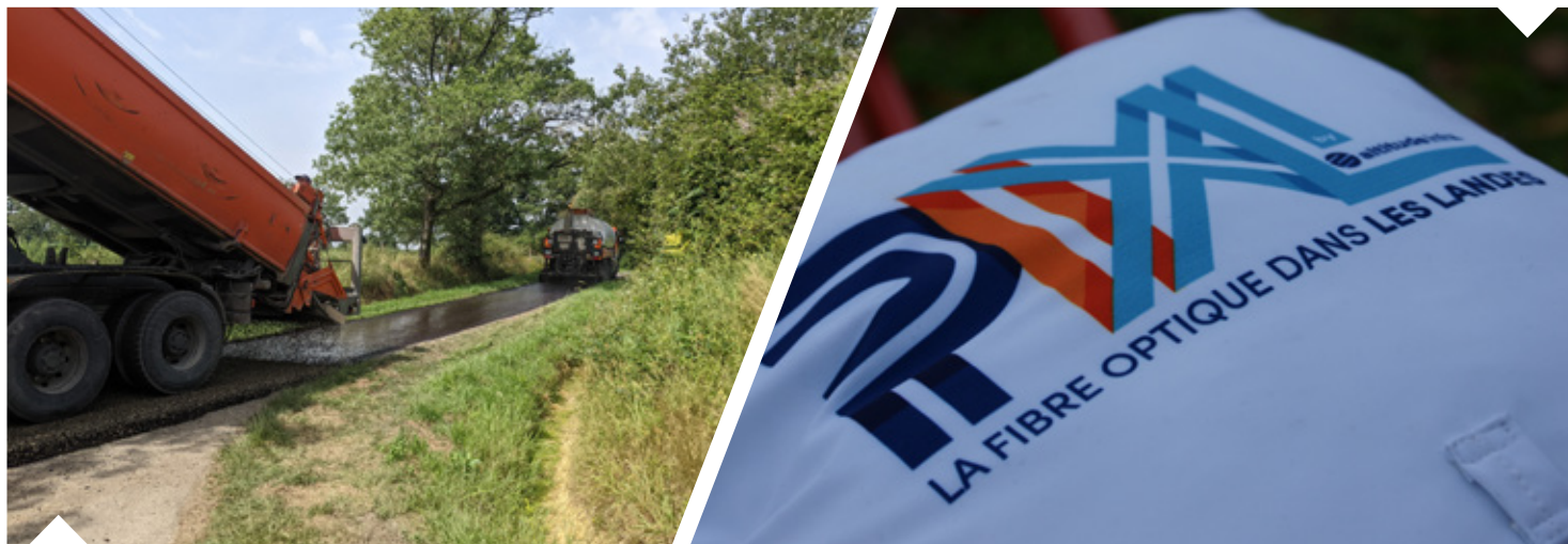
38 500 m 2 de chaussée ont été traités en 2021.
