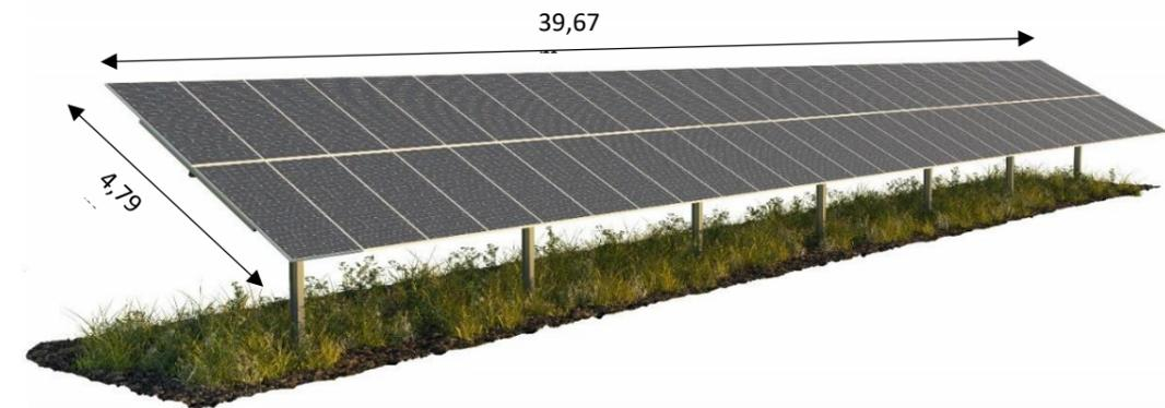
Afin de garantir la présence de lumière à la végétation et de faciliter l'exploitation agricole sous les panneaux, le point bas des modules se trouvent à 1,2 mètres minimum au-dessus du sol.
